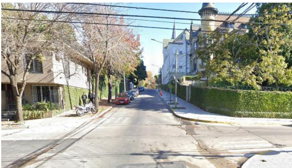
CALLE ÁLVAREZ SOBRE LA ANTIGUA BARRANCA (ENTRE GASPAR CAMPOS Y E. MADERO), VISTA AL O. A LA DERECHA SE OBSERVA LA CASONA DENTRO DEL COLEGIO MICHAEL HAM
