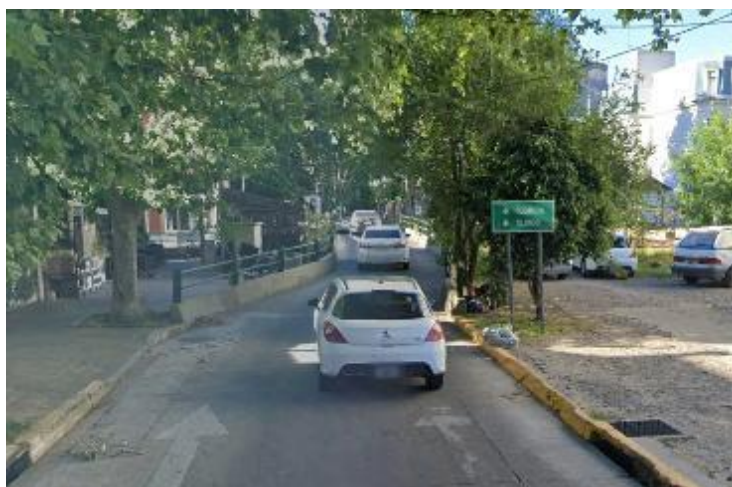
PUENTE DE LA CALLE AZCUÉNAGA SOBRE MELO, VISTA HACIA ESTACIÓN VICENTE LÓPEZ
