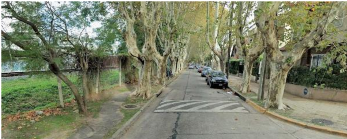
FORESTACIÓN CALLE AZCUÉNAGA, VISTA AL SUR. A LA IZQUIERDA SE OBSERVA EL JACARANDÁ Y DETRÁS EL SITIO DE IMPLANTACIÓN DE LA SER DENTRO DE LA ZONA DE VÍAS.
